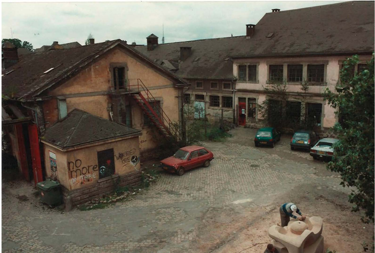
La Kulturaufabrik en 1995, peu avant les rénovations
